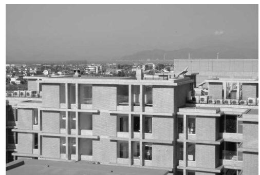
写真 - 5 屋上全景
